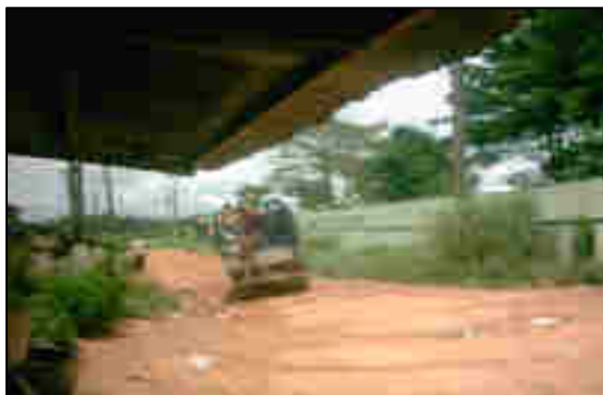
Photo 4 : La route est dans un état de dégradé. Ici un camion benne transporte des passagers d'Alépé à Abrotchi. Photographie : Adomon, septembre, 2010
