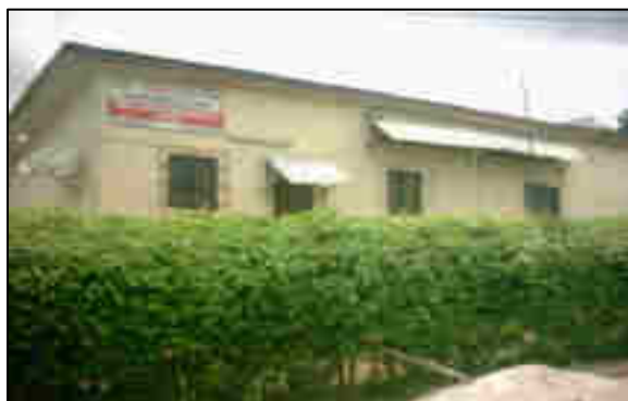
Photo n° 1 : Habitation coloniale réhabilitée. Local du ministère de la construction et de l'urbanisme. Photographie : Adomon, Août, 2009
